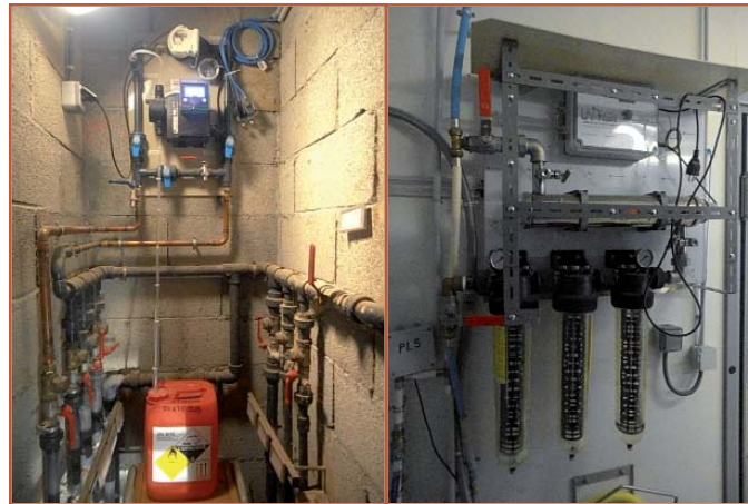
Les dispositifs de traitements de l'eau testés à la station du Pradel : à gauche, pompe à peroxyde - à droite, lampe à UV
